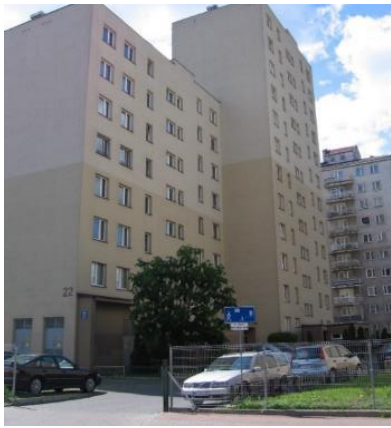
Fotografia: Osiedle blokowe przy ulicach: Józefa Formińskiego i Kolejowej
