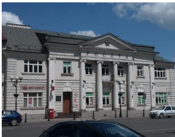
Fotografia: Zabytkowy, odrestaurowany budynek Poczty przy ul. J. Piłsudskiego
