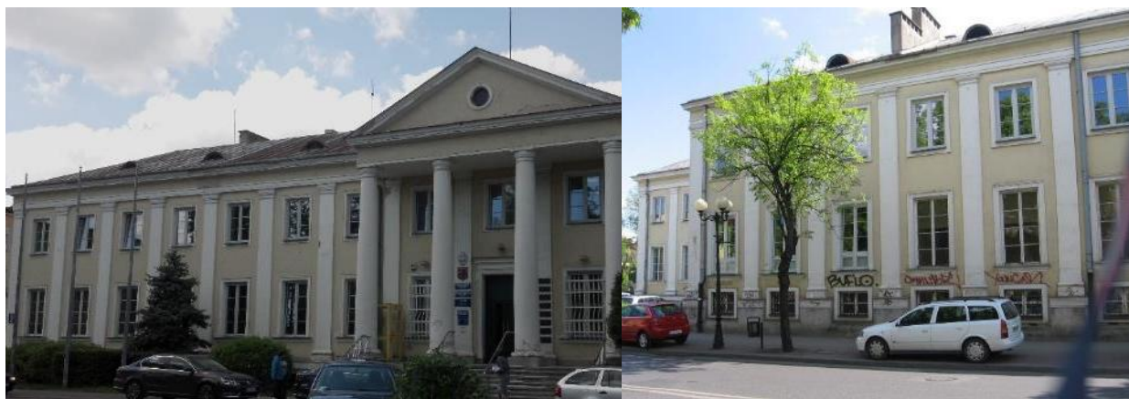
Fotografie: Budynek Urzędu Miasta Siedlce – widok odpowiednio: od Skweru Niepodległości i od ul. J. Piłsudskiego
