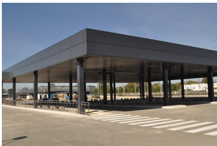
Fotografia: Centrum przesiadkowe przy ul. Rotmistrza Witolda Pileckiego.
