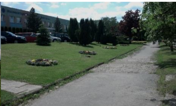
Fotografia: Zniszczony i wybrakowany ciąg pieszy przy ul. Księcia Józefa Poniatowskiego, w bezpośrednim sąsiedztwie Mazowieckiego Szpitala Wojewódzkiego przed realizacją projektu.
