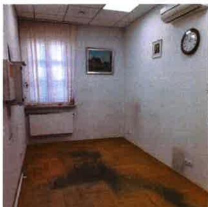
Wygląd podłogi i ścian przed remontem
