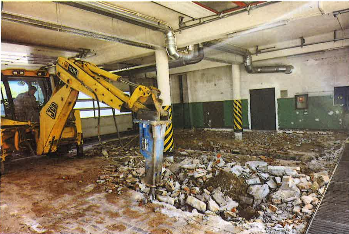
Fot. Remont posadzki garażu JRG nr 2
