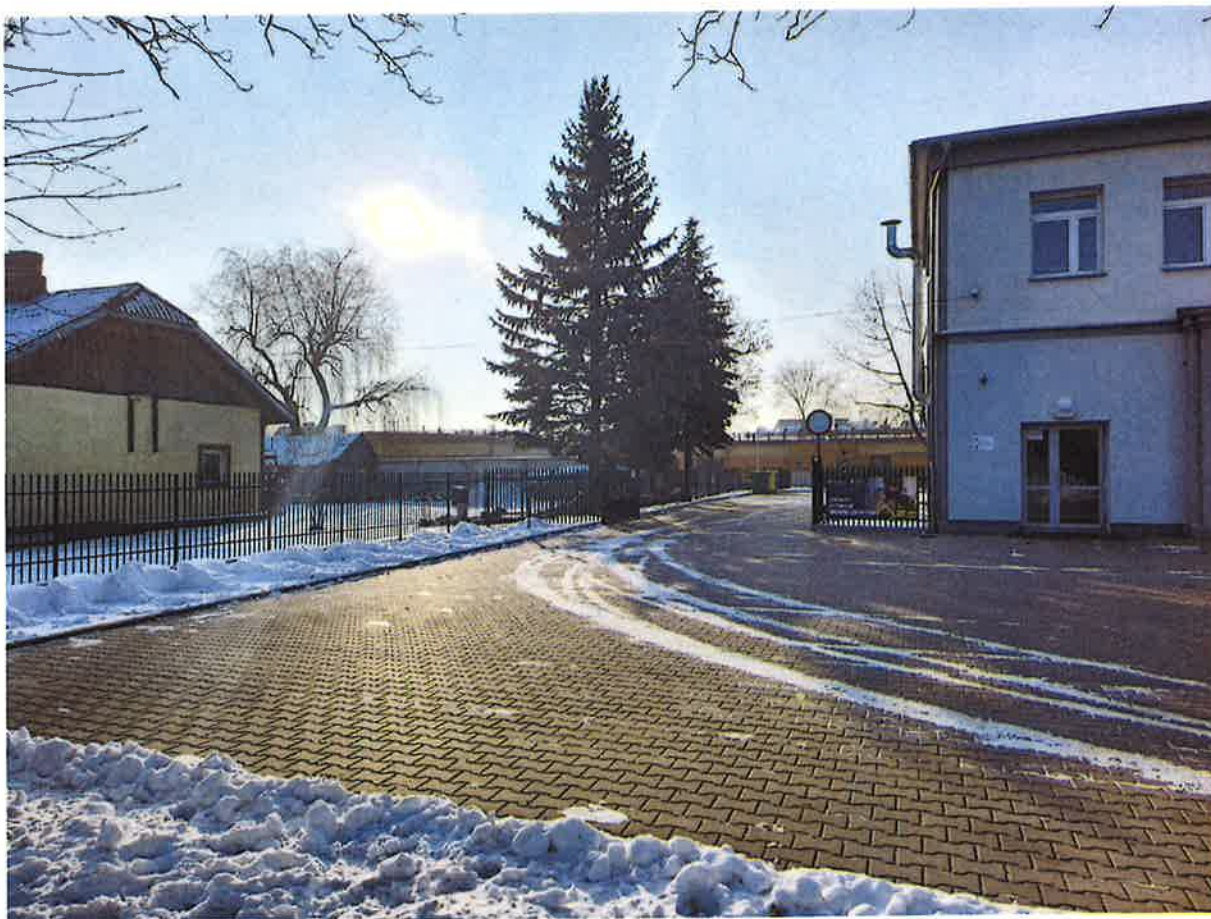
Fot. Remont ogrodzenia JRG 2.
