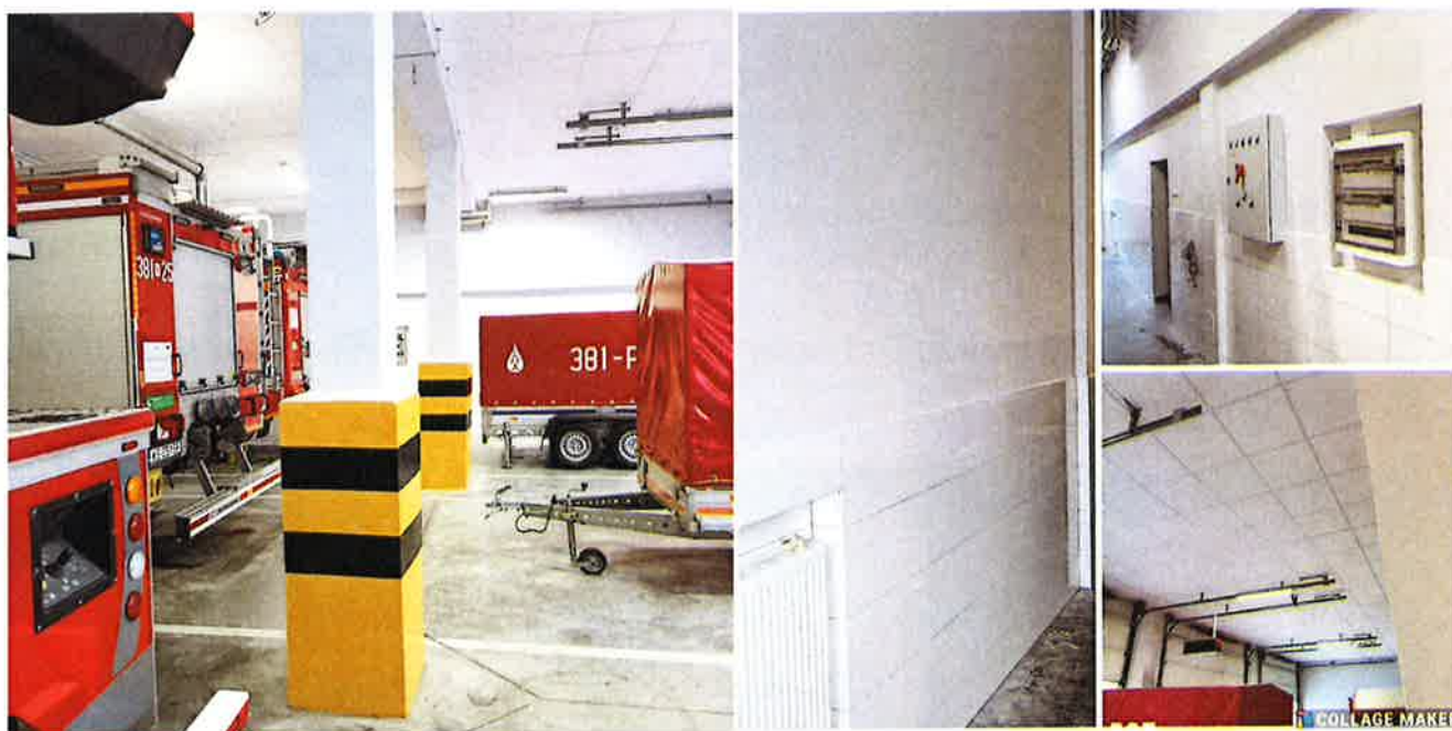
Fot. Remont garażu nr 1
