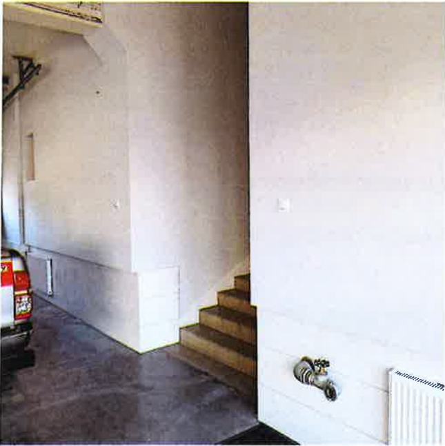
Fot. Remont garażu nr 2
