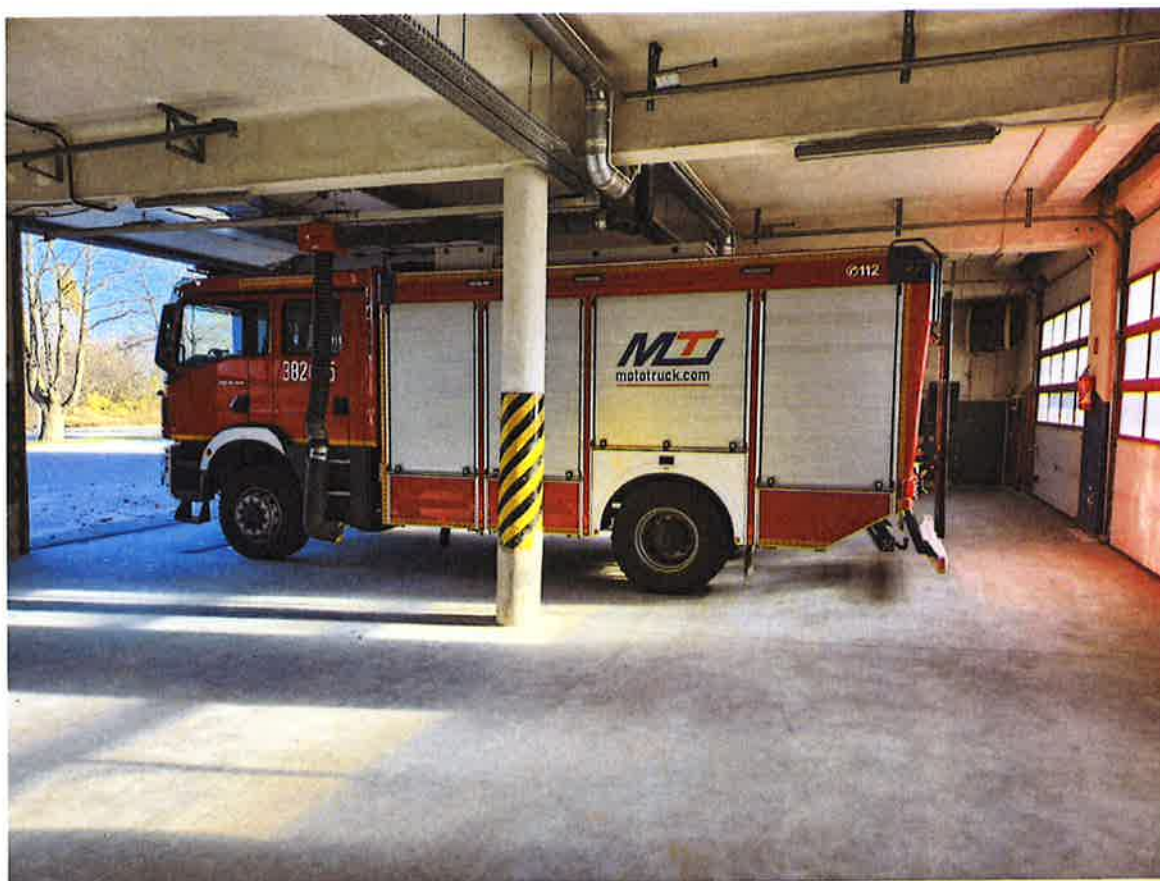
Fot. Wyremontowana posadzka garażu JRG nr 2
