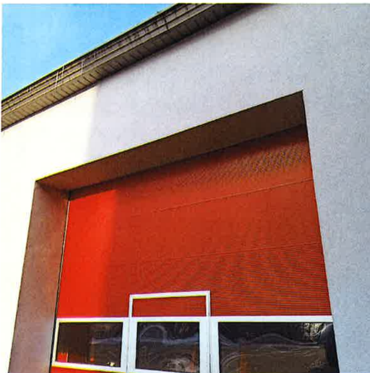
Fot. Remont ościeży bram
