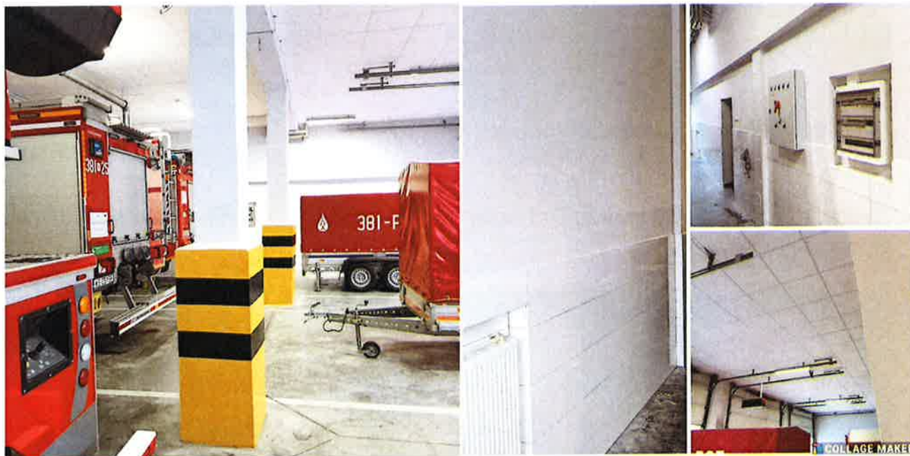
Fot. Remont garażu nr 1
