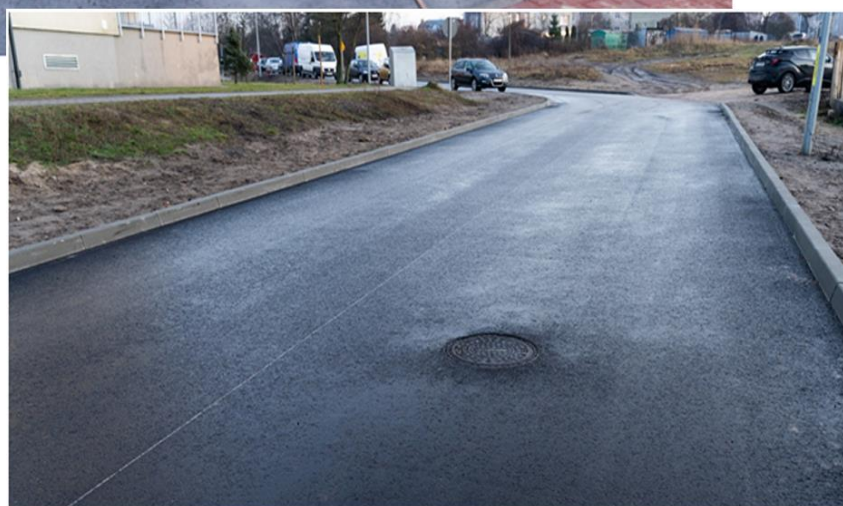
Fot. Budowa trwałej nawierzchni jezdni ul. Gen. Maczka - odcinek od ul. Pescantina.
