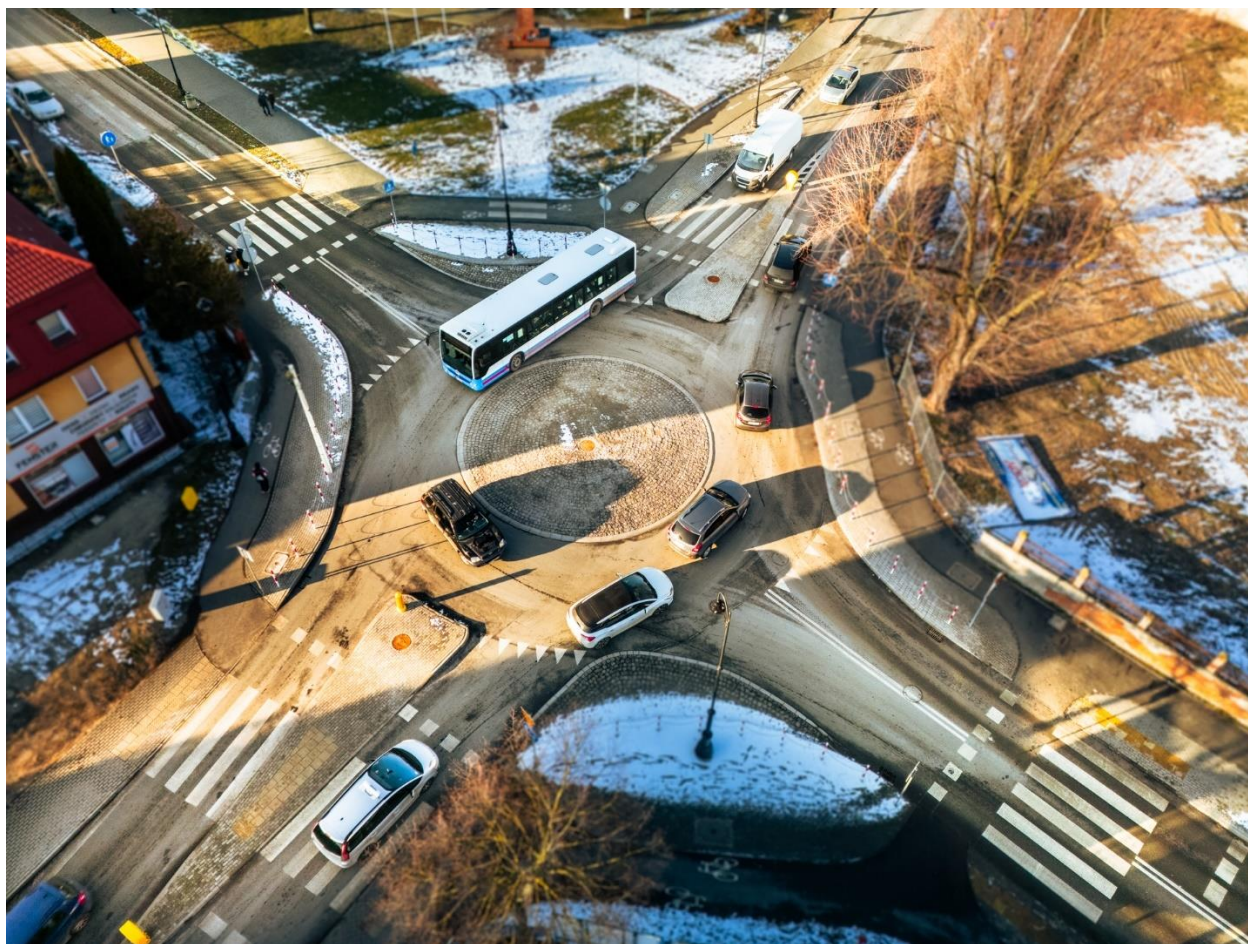
Fot. Rozbudowa ulicy Cmentarnej w Siedlcach, odcinek od ul. ks. J.Niedziałka do ulicy Wojskowej
