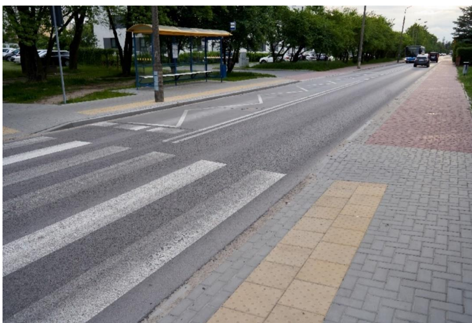
Fot. Przebudowa ulicy Ignacego Kraszewskiego, na odcinku od skrzyżowania z ul. Mazurską/C. Norwida do skrzyżowania z ul. Benedyktowicza w Siedlcach
