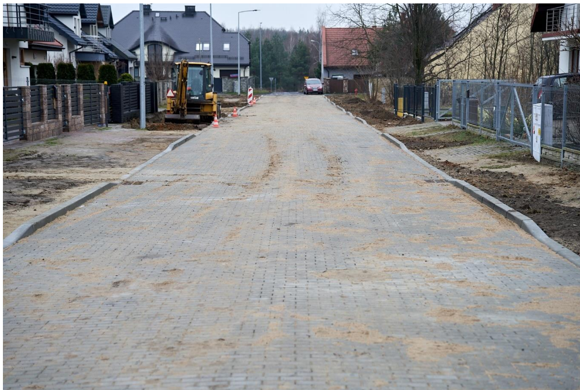
Fot. Budowa ul. Liliowej wraz z odwodnieniem i wykonaniem nawierzchni z kostki brukowej.
