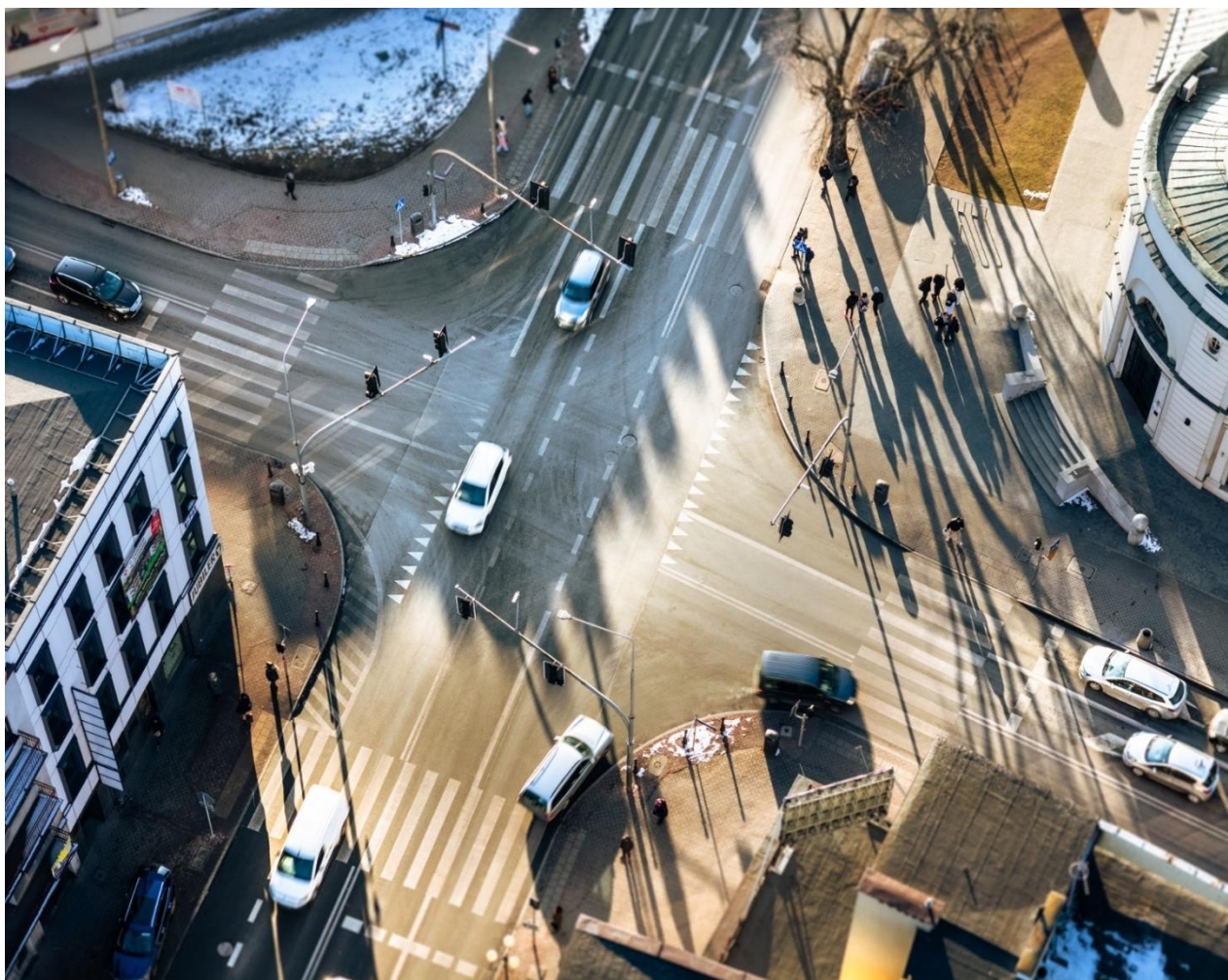
Remont nawierzchni ulicy Armii Krajowej i ulicy Wojskowej wraz ze skrzyżowaniem z ulicą J. Piłsudskiego.
