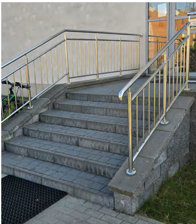
Zd.8 Widok schodów zewnętrznych przeznaczonych do rozbiórki
