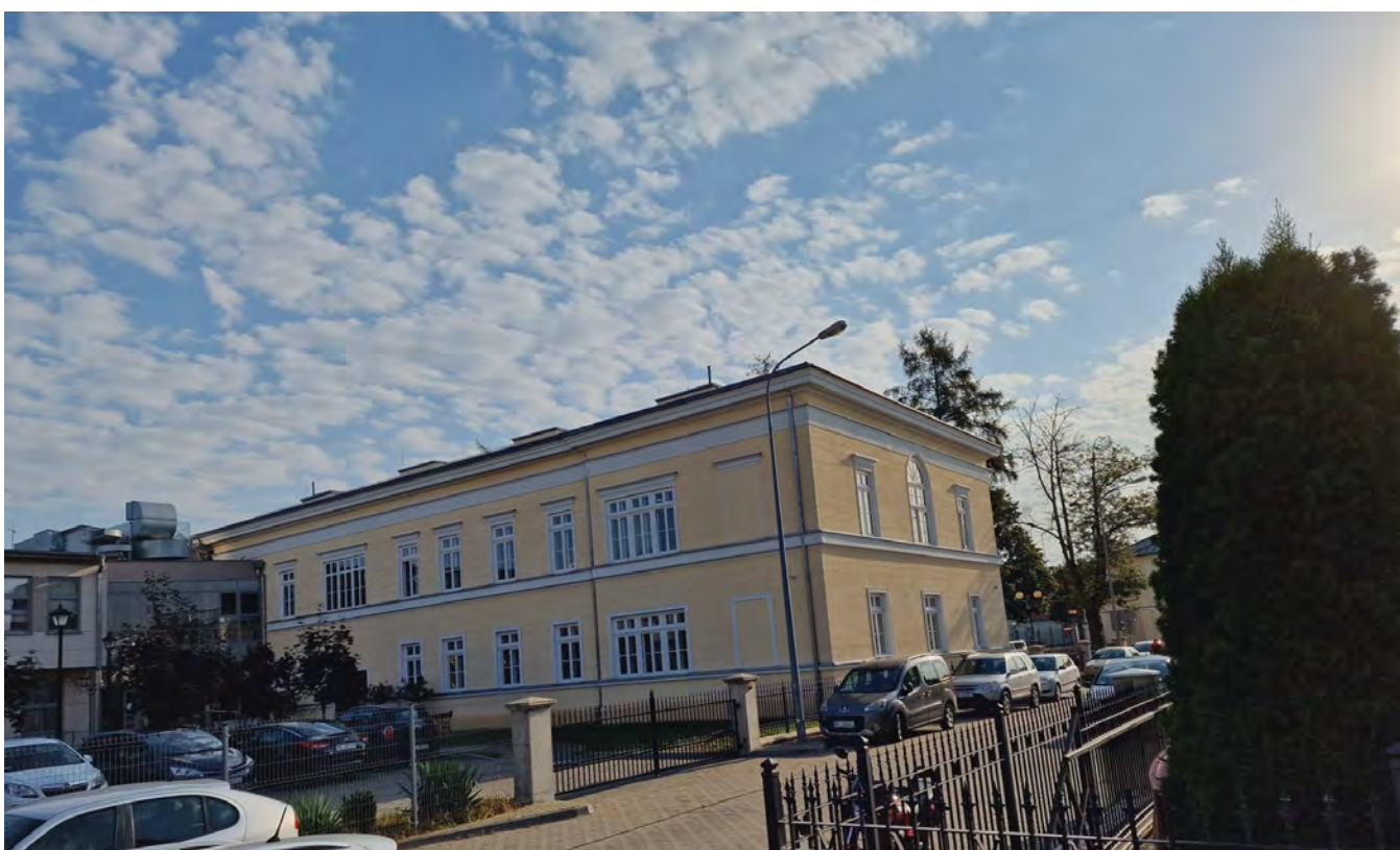
Zd.3 Widok konstrukcji budynku – część zabytkowa
