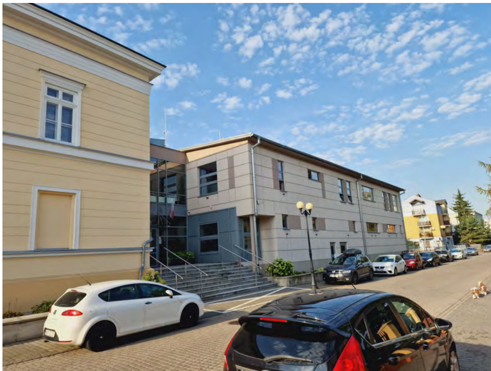
Zd.4 Widok elewacji frontowej budynku
