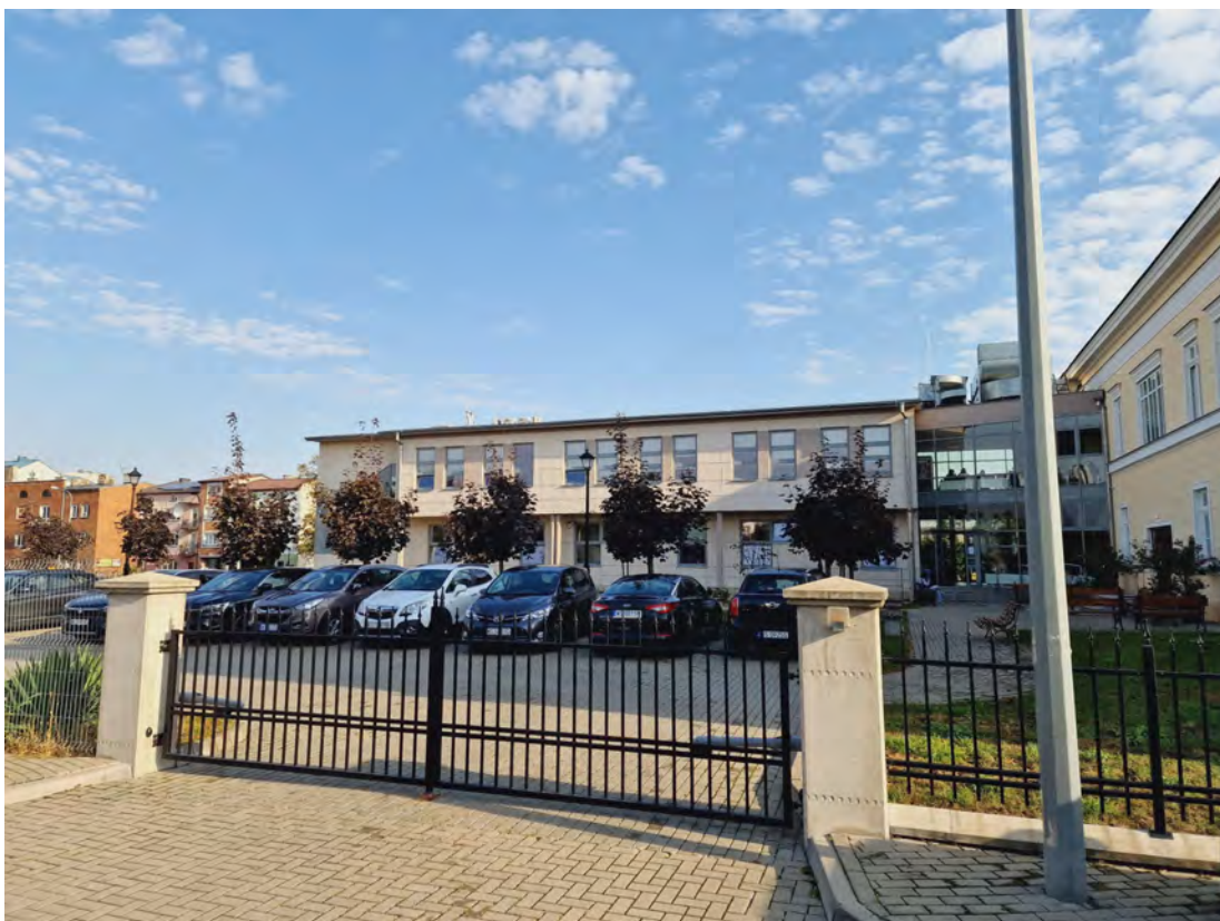
Zd.2 Widok konstrukcji budynku – nowa część
